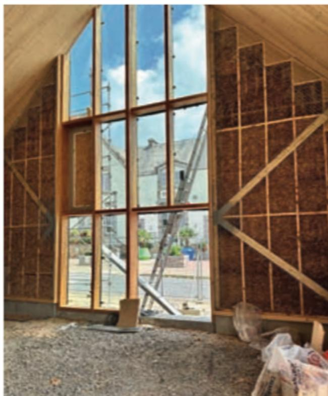
Façade sur rue en cours de construction : panneaux de paille compressée.
